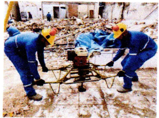
Figura 2 - Local da sondagem
